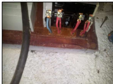
plusieurs conducteurs sous bornes
