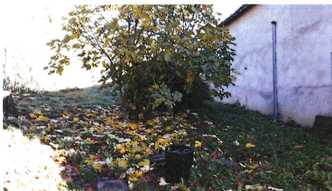
Fosse toutes eaux et ventilation primaire associée
