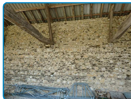
Autre4 Rez de chaussée Hangar
