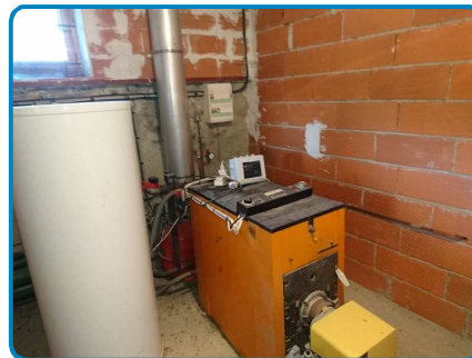
Autre Rez de chaussée Chaufferie
