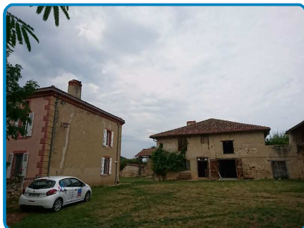
Maison principale Rez de chaussée Extérieur
