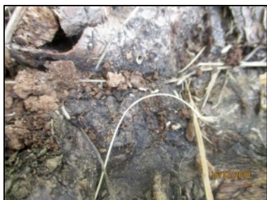
Abris bois : indice d'infestation de termites avec activité d'insectes.
