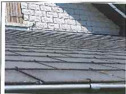
Photo n° PhA001 Localisation : annexe - abri voiture Ouvrage : 1 - Couvertures, Toitures, Terrasses et étanchéités - Ardoises, bardeaux bitumineux Partie d'ouvrage : Ardoises composites hors fibro ciment Description : Ardoises composites hors fibro ciment
