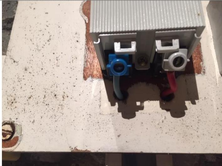
Description : La section des CONDUCTEURS de la CANALISATION alimentant le seul tableau n'est pas adaptée au courant de réglage du DISJONCTEUR de branchement.
