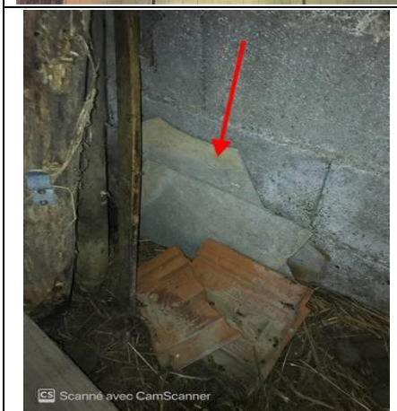
Photo n° PhA002 Localisation : Rez de chaussée - Hangar Ouvrage : Bardages et façades légères Partie d'ouvrage : Plaques (fibres-ciment) Description : Plaques (fibres-ciment) Localisation sur croquis : ZPSO-002
