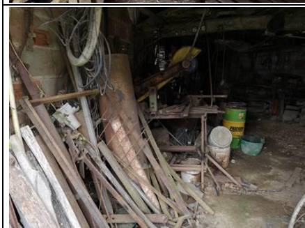
Photo n° 2 Localisation : Annexe - Atelier Ouvrage : Sol et bas des murs Description : Le sol et le bas des murs ne sont pas visibles et accessibles en raison de l'encombrement du bas de la pièce.
