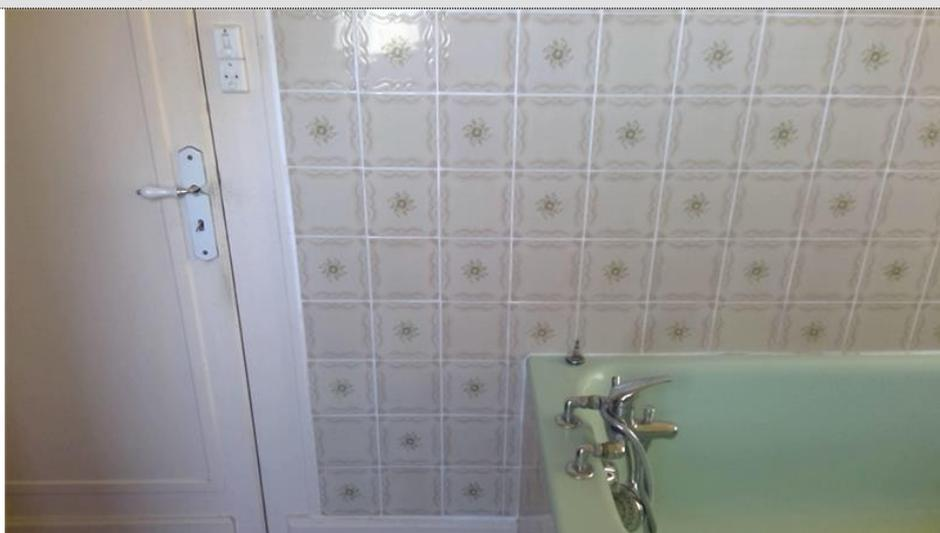
Description : Local contenant une baignoire ou une douche : l'installation électrique ne répond pas aux prescriptions particulières appliquées à ce local (adéquation entre l'emplacement où est installé le MATERIEL ELECTRIQUE et les caractéristiques de ce dernier – respect des règles de protection contre les chocs électriques liées aux zones).
