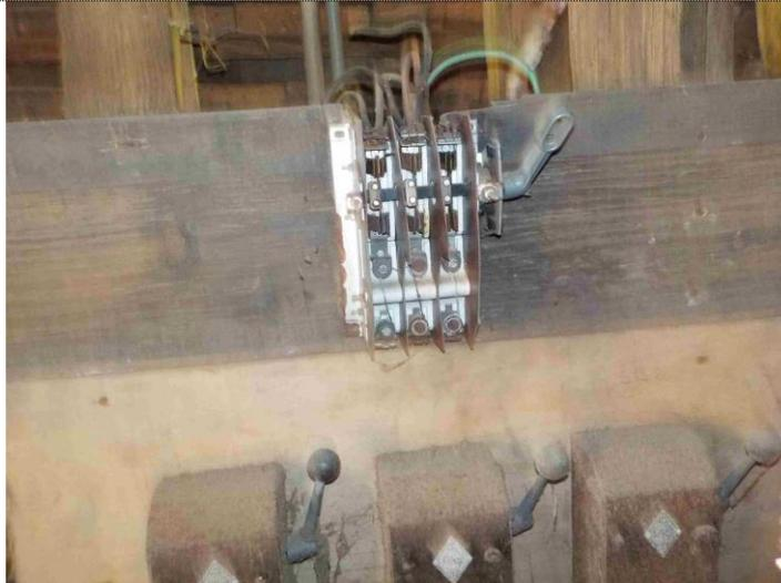
Description : Au moins un CONDUCTEUR nu et/ou au moins une partie accessible est alimenté sous une tension > 25 V a.c. ou > 60 V d.c. ou est alimenté par une source autre que TBTS.
