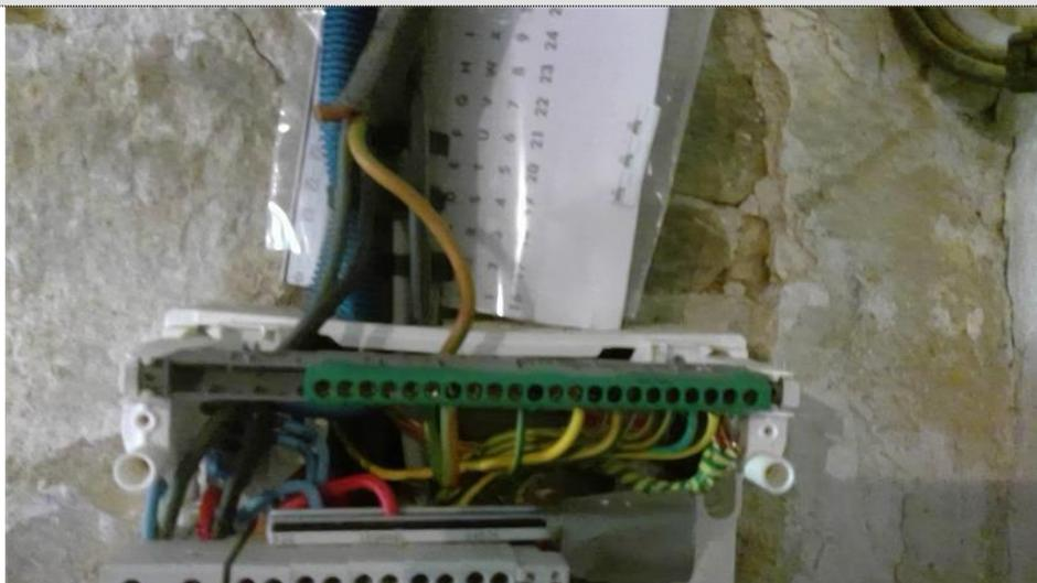
Description : La section des CONDUCTEURS de la CANALISATION d'alimentation d'au moins un tableau n'est pas en adéquation avec le courant assigné du dispositif de protection placé immédiatement en amont ou avec le courant de réglage du DISJONCTEUR de branchement placé immédiatement en amont.
