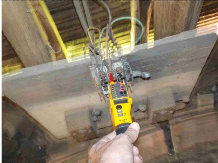
Description : L'installation électrique comporte au moins un dispositif de protection avec une partie active nue sous tension accessible.
