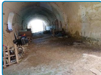
Château Rez de chaussée Grange
