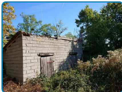
Dépendance n°2 RDC Débarras n°2
