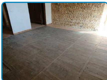
Gîte F2 Rez de chaussée Séjour
