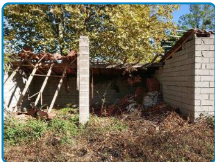
Dépendance n°2 Rez de chaussée Grange
