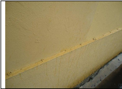
Photo n° DSCN005 Localisation : Façade Ouvrage : Façade
