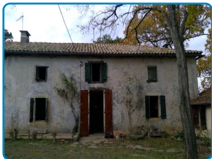
Maison principale Rez de chaussée Extérieur
