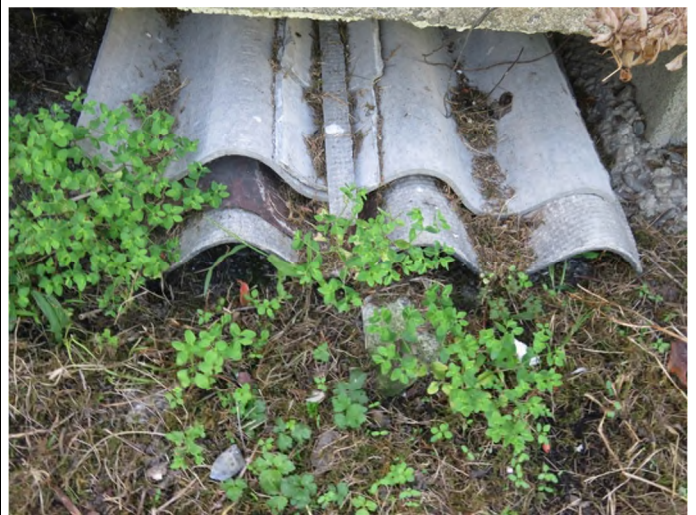
Plaques ondulées en amiante ciment stockés à terre cuisine été
