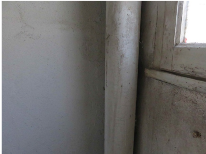
Conduit amiante ciment toilettes RDC
