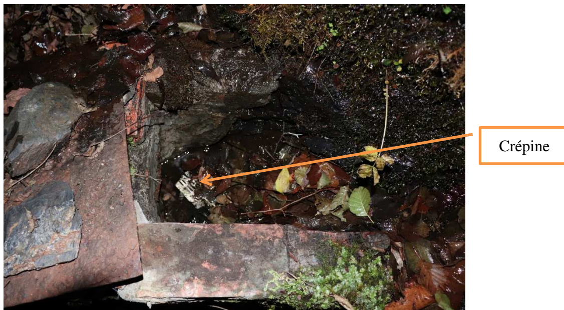
Figure 5 – Vue sur l'intérieur de l'ouvrage
