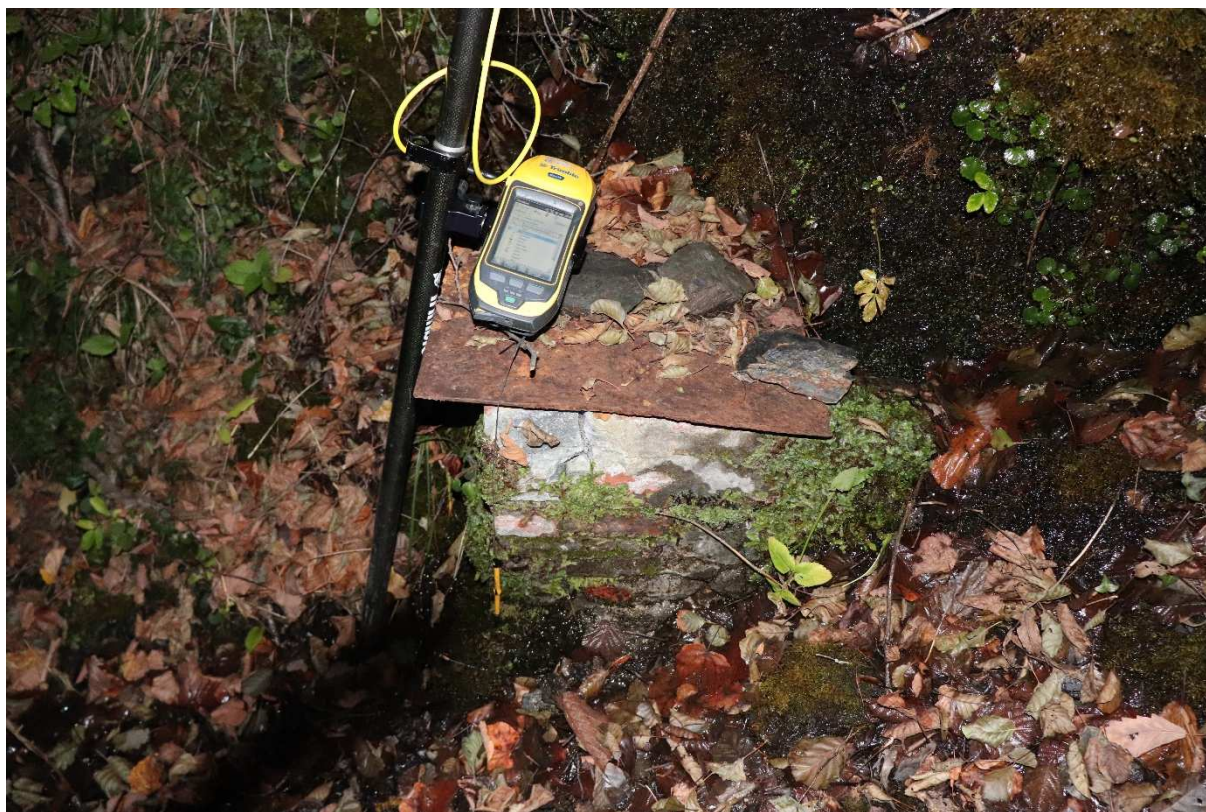
Figure 4 – Vue sur l'ouvrage existant
