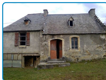
Maison principale 2 Rez de chaussée Extérieur
