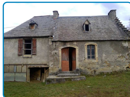
Maison principale 2 Rez de chaussée Extérieur
