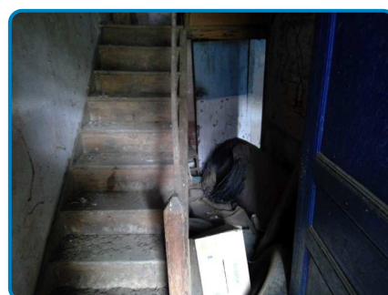
Maison principale 1 Rez de chaussée Cage escalier
