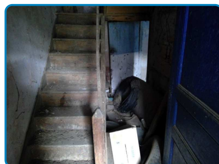
Maison principale 1 Rez de chaussée Cage escalier
