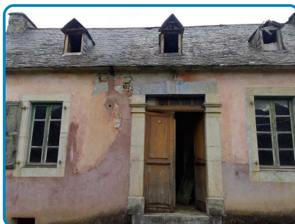
Maison principale 1 Rez de chaussée Extérieur
