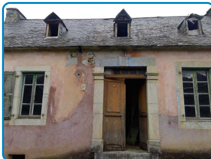
Maison principale 1 Rez de chaussée Extérieur
