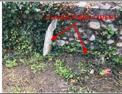
Photo n° PhA001 Localisation : Rez de chaussée - Extérieur Ouvrage : Toitures Partie d'ouvrage : Plaques (fibres-ciment) Description : Plaques (fibres-ciment) Localisation sur croquis : ZPSO-001
