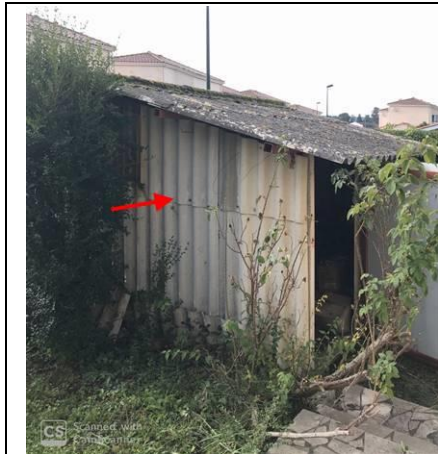
Photo n° PhA004 Localisation : Rez de jardin - Abris de jardin Ouvrage : Murs, Cloisons "en dur" et Poteaux (périphériques et intérieurs) Partie d'ouvrage : Revêtements durs (amiante-ciment) Description : Plaques ondulées (amiante-ciment) Localisation sur croquis : ZPSO-004
