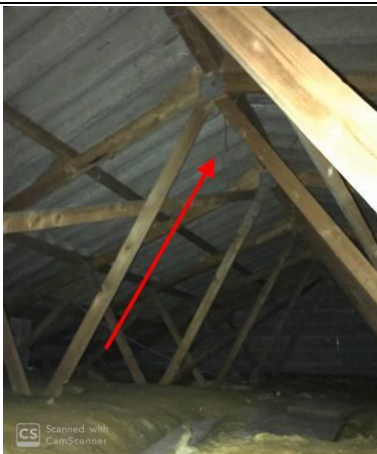
Photo n° PhA002 Localisation : 1er étage - Combles Ouvrage : Toitures Partie d'ouvrage : Plaques (fibres-ciment) Description : Plaques (fibres-ciment) Localisation sur croquis : ZPSO-002
