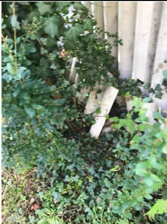
Photo n° PhA005 Localisation : Rez de jardin - Extérieur Ouvrage : Toitures Partie d'ouvrage : Plaques (fibres-ciment) Description : Plaques (fibres-ciment)
