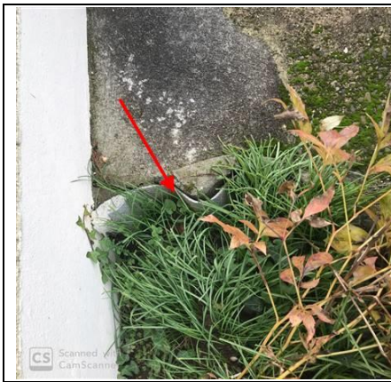
Photo n° PhA005 Localisation : Rez de jardin - Extérieur Ouvrage : Toitures Partie d'ouvrage : Plaques (fibres-ciment) Description : Plaques (fibres-ciment)
