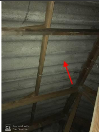
Photo n° PhA002 Localisation : 1er étage - Combles Ouvrage : Toitures Partie d'ouvrage : Plaques (fibres-ciment) Description : Plaques (fibres-ciment) Localisation sur croquis : ZPSO-002
