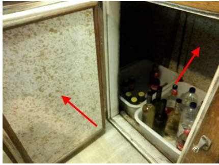
Photo n° PhA003 Localisation : Rez de chaussée - Bar/Salle Ouvrage : 2 - Parois verticales extérieures et Façades - Façades légères, murs rideaux, bardages, panneaux sandwich Partie d'ouvrage : Plaques Description : Plaques
