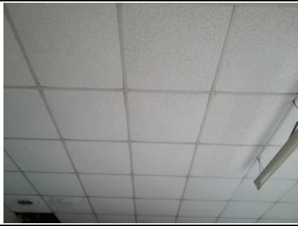
Photo n° PhA002 Localisation : Rez de chaussée - Réserve 1; Rez de chaussée - Réserve 2 Ouvrage : 4 - Plafonds et faux plafonds - Faux plafonds Partie d'ouvrage : Panneaux et plaques Description : Panneaux et plaques
