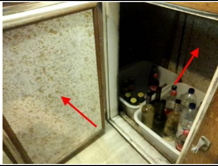
Photo n° PhA003 Localisation : Rez de chaussée - Bar/Salle Ouvrage : 2 - Parois verticales extérieures et Façades - Façades légères, murs rideaux, bardages, panneaux sandwich Partie d'ouvrage : Plaques Description : Plaques
