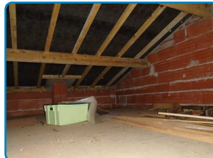
Dépendance 1er étage Grenier
