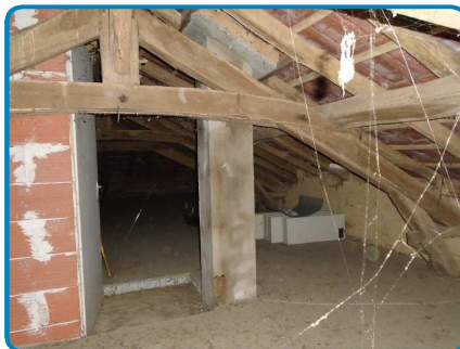
Maison principale 2ème étage Combles
