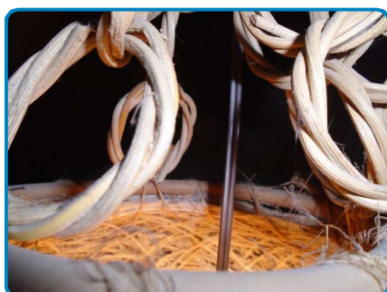
Anomalie B.8.3 d sur Install. n°1
