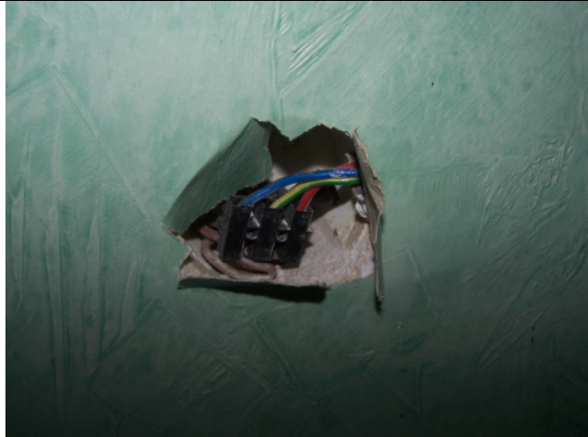
Connexion et conducteurs non protégés
