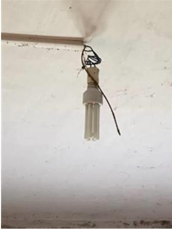
Photo Douille de chantier + Conducteurs apparents
