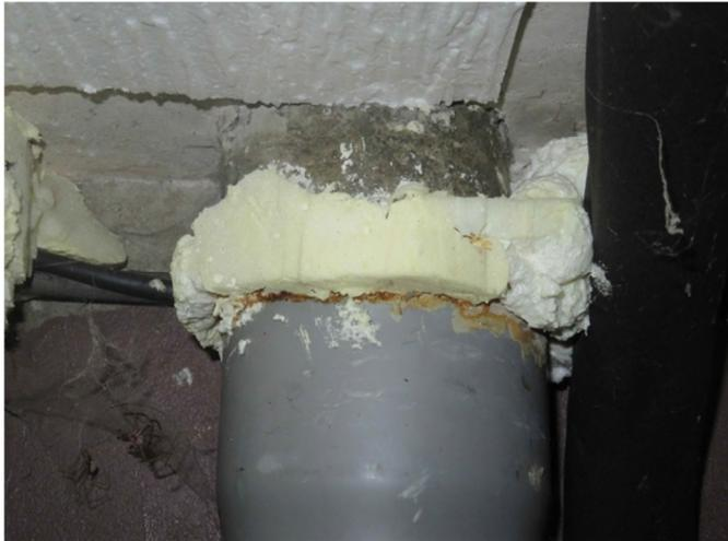
Bas de conduit en amiante ciment sous sol
