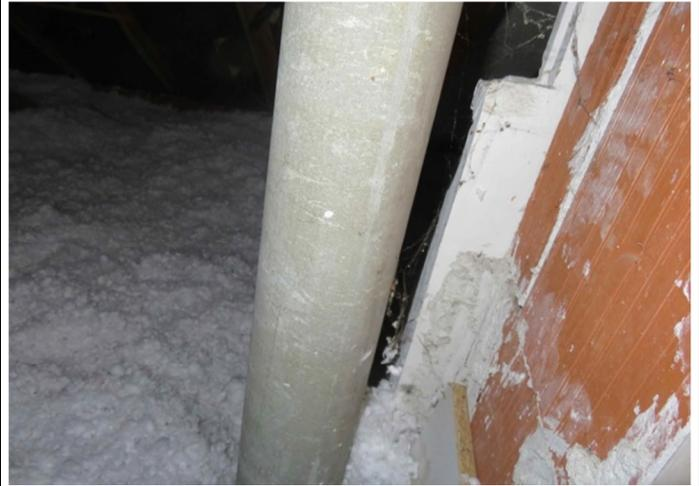
Conduit en amiante ciment combles 1
