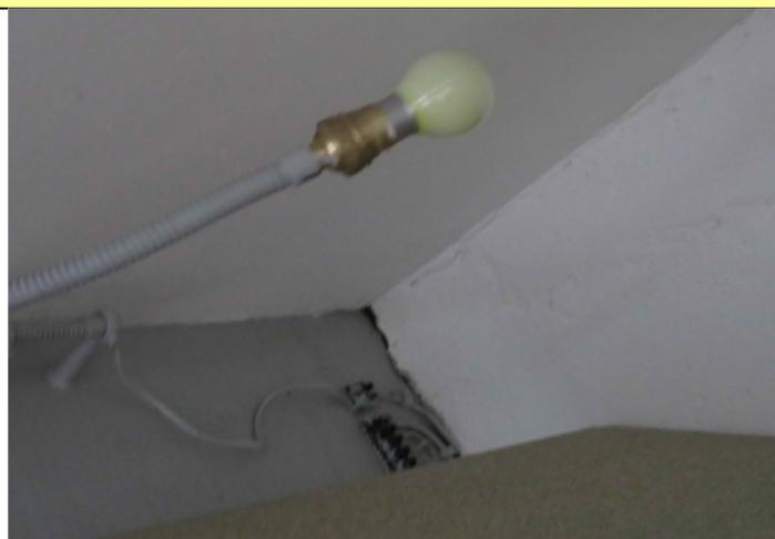
Douille métallique et connexion non protégé ch 6 R
