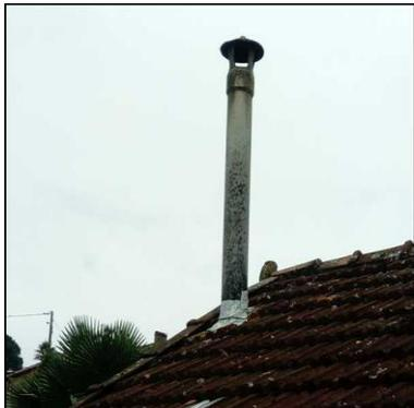
conduit en fibre ciment en toiture et sur le mur extérieur de la maison
