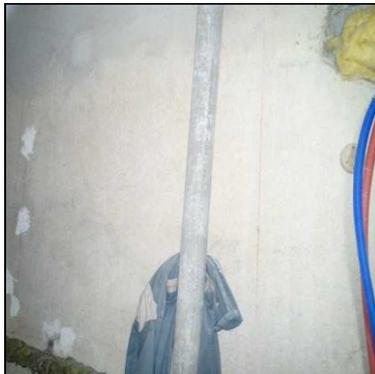
conduit en fibre ciment au mur de la pièce
