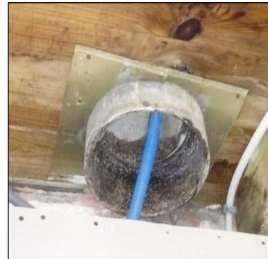
conduit en fibre ciment au plafond du garage
