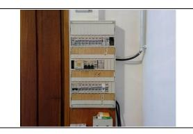
Photo n° PhEle001 B11 a3 Il n'y a aucun dispositif différentiel à haute sensibilité inf. ou égal à 30 mA.
