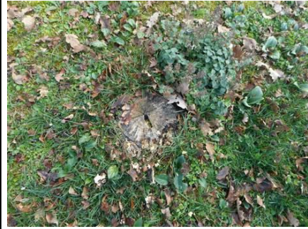
Photo n° PhTer002 Localisation : Parties extérieures Ouvrage : bois au sol, souches Informations complémentaires : bois piqué, décoloration du bois - Parasite(s) identifié(s) : Champignon de pourriture cubique, Insectes à larves xylophages
