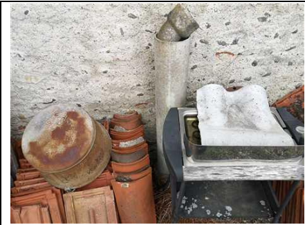
Photo n° PhA004 Localisation : Parties extérieures Ouvrage : 6 - Conduits et accessoires intérieurs - Conduits de fluides (air, eau, vapeur, fumée, échappement, autres fluides) Partie d'ouvrage : Conduit en fibres-ciment Description : Conduit en fibres-ciment en dépôts Localisation sur croquis : M004
