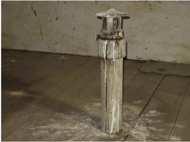
Conduit de ventilation en amiante ciment salle de bain débouchant dans les combles
