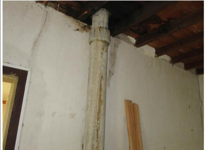
Conduit de ventilation en amiante ciment salle de bain Débouchant dans la pièce 1
