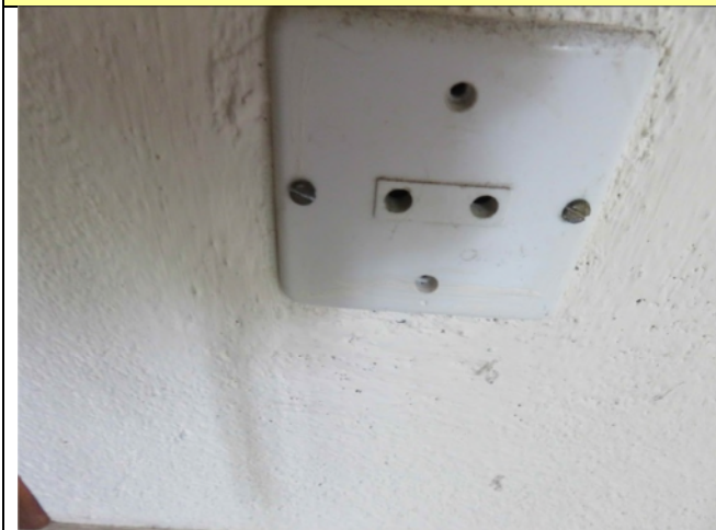
Prise simple non obturé, sans broche de terre local chaudière
