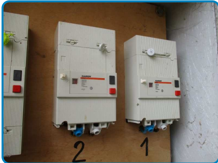
Anomalie B.1.3 b sur Install. n°1 (AGCP)
