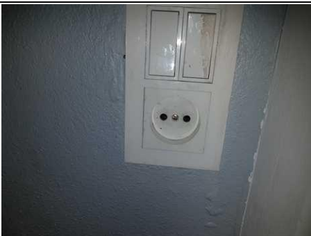
Photo PhEle001 Libellé de l'anomalie : B3.3.6 a1 Au moins un socle de prise de courant ne comporte pas de broche de terre.
