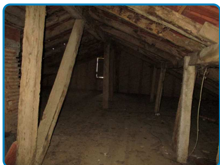
Maison principale 2ème étage Combles
