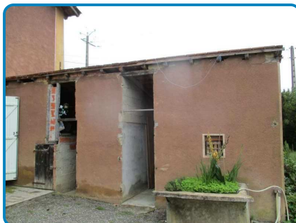
Dépendance Rez de chaussée Porcherie n°2
