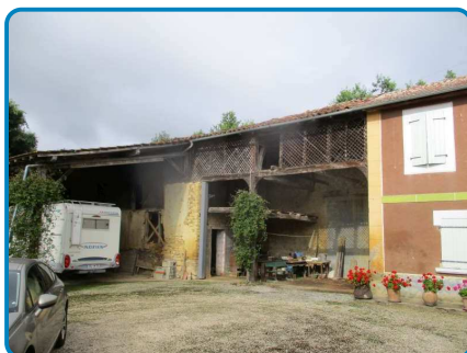
Dépendance Rez de chaussée Extérieur
