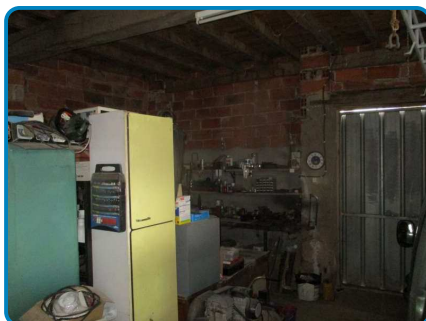
Maison principale Rez de chaussée Garage
