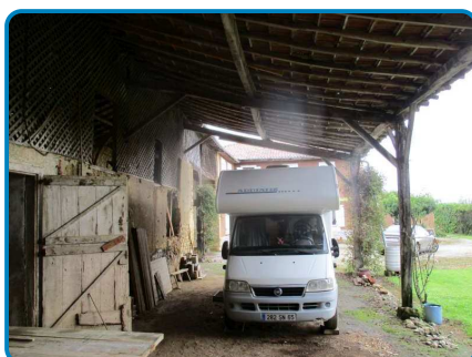
Dépendance Rez de chaussée Auvent
