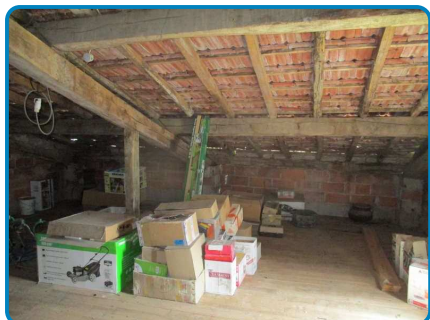
Maison principale 1er étage Grenier n°2
