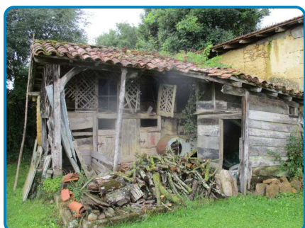
Dépendance Rez de chaussée Porcherie n°1
