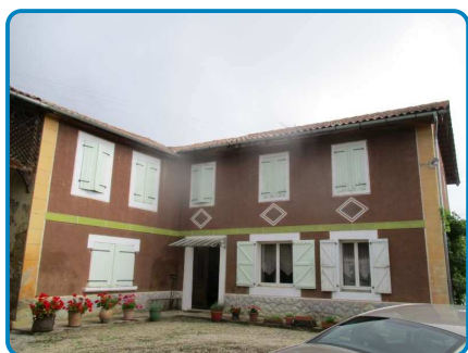
Maison principale Rez de chaussée Extérieur
