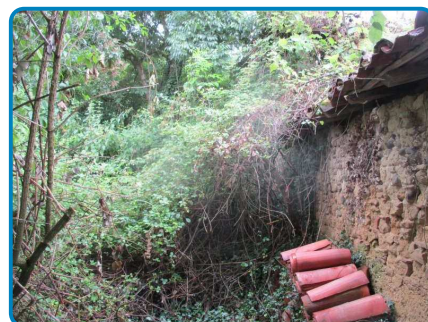
Dépendance Rez de chaussée Extérieur
