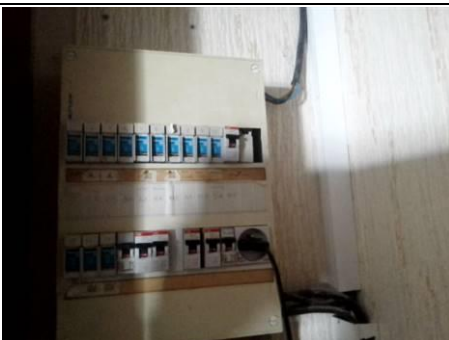
Photo n° PhEle001 B11 a3 Il n'y a aucun dispositif différentiel à haute sensibilité inf. ou égal à 30 mA.
