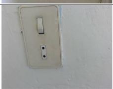
Au moins un socle de prise de courant ne possède pas un puits de 15 mm.
