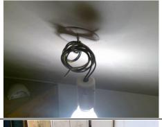
Au moins un conducteur isolé n'est pas placé sur toute sa longueur dans un conduit, une goulotte ou une plinthe ou une huisserie, en matière isolante ou métallique, jusqu'à sa pénétration dans le matériel électrique qu'il alimente.
