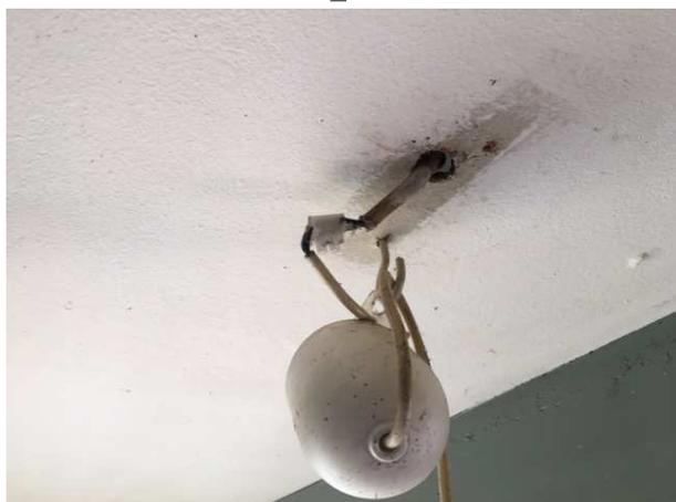
Au moins un CONDUCTEUR isolé n'est pas placé sur toute sa longueur dans un conduit, une goulotte, une plinthe ou une huisserie, en matière isolante ou métallique, jusqu'à sa pénétration dans le MATERIEL ELECTRIQUE qu'il alimente.
