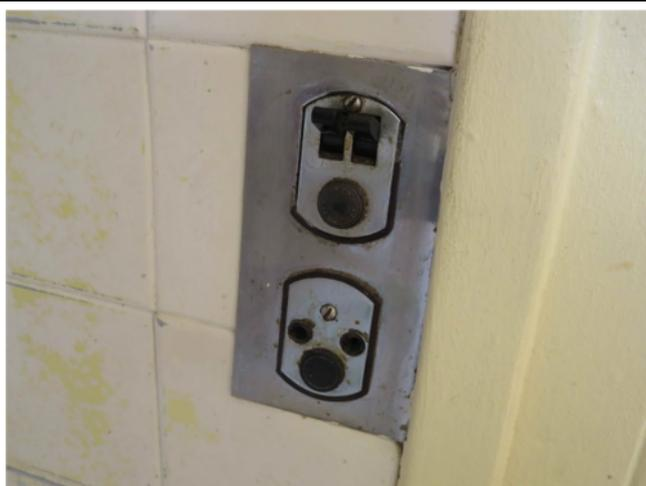
Interrupteur et prises avec façades métalliques et fusibles intégrés, prise sans broche de terre, non obturé et sans puits
