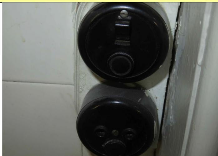
Interrupteur et prises avec fusibles intégrés, prise sans broche de terre, non obturé et sans puits
