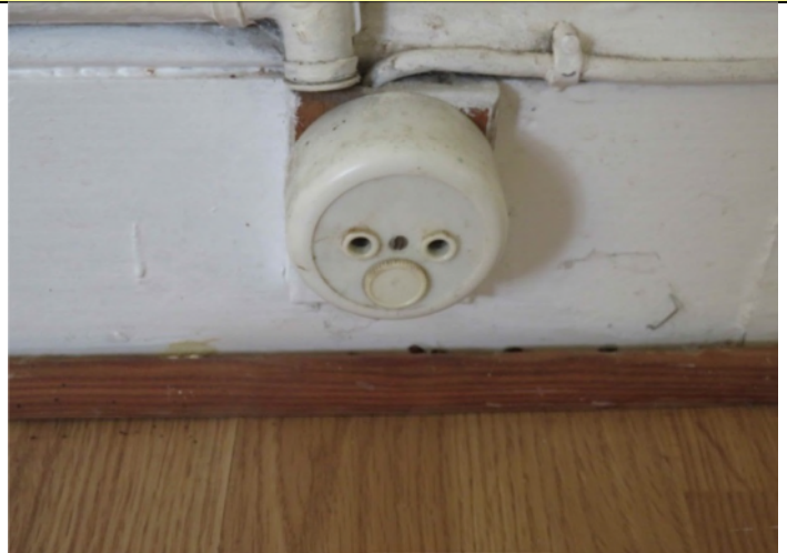
Prise sans broche de terre , non obturée sans puits et avec fusible intégré pièce1
