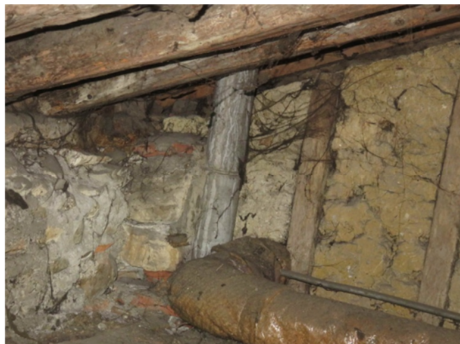
Conduit en amiante ciment combles
