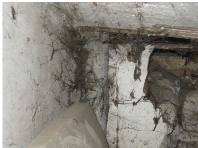
Conduit en amiante ciment combles
