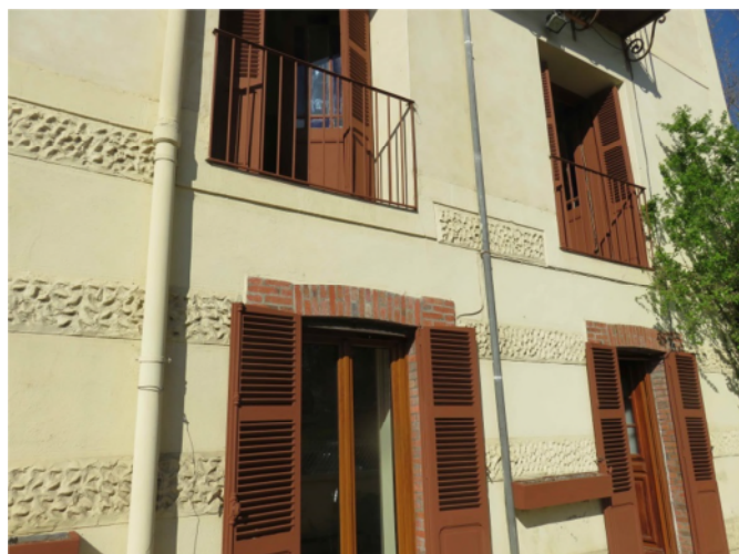
Conduit en amiante ciment façade mur extérieur côté Est
