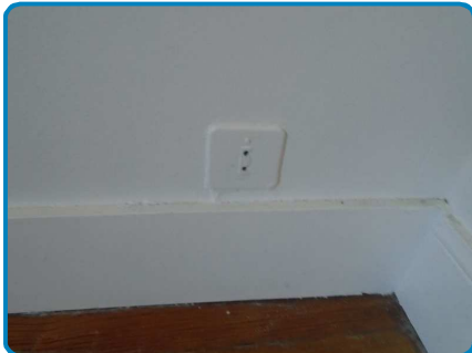
Anomalie B.3.3.6 a1 sur Install. n°1
