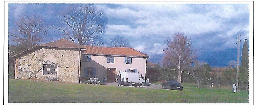
Vue N°2 / vue des façades Sud habitation et grange existante
