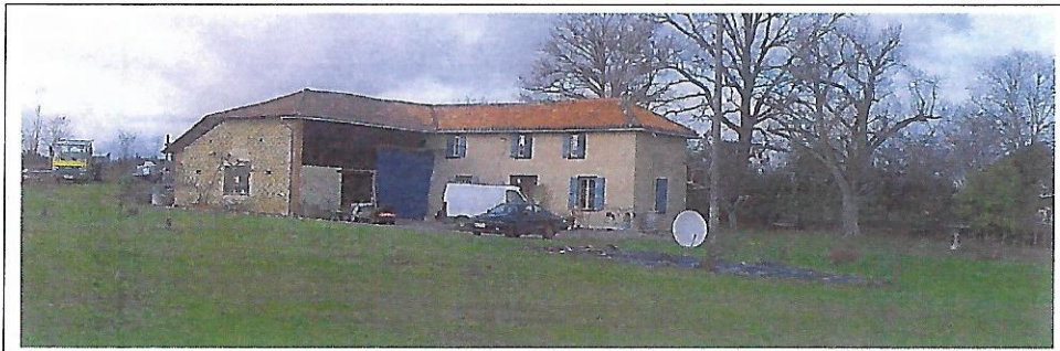
Vue N°3 / vue des façades Su et Est de l'habitation et de la grange existante
