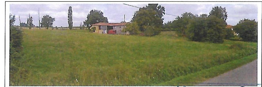
Vue N°4 / vue lointaine Google Earth de l'ensemble bâti existant
