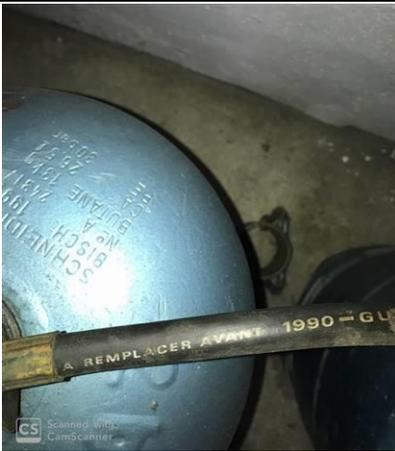
7d4 : La date limite d'utilisation de la lyre GPL en caoutchouc armé n'est pas lisible ou est dépassée.
