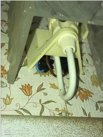
Au moins un conducteur nu et/ou au moins une partie accessible est alimenté sous une tension supérieure à 25 V a.c. ou supérieure ou égale 60 V d.c. ou est alimenté par une source autre que TBTS.
