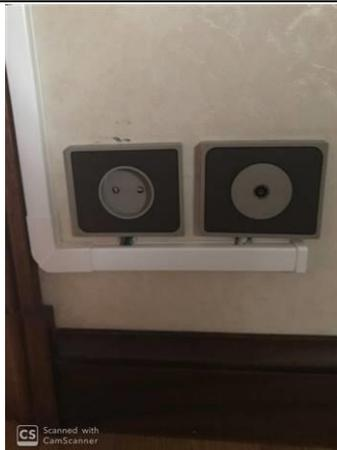
Au moins un socle de prise de courant ne possède pas un puits de 15 mm.
