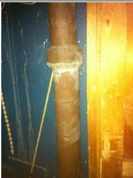
Photo n° DSCN013 Localisation : Étage 2 - Placard 1 Ouvrage : Conduits de fluides (air, eaux, autres fluides) Partie d'ouvrage : Conduits fibres-ciment Description : Conduits fibres-ciment Localisation sur croquis : Point 013
