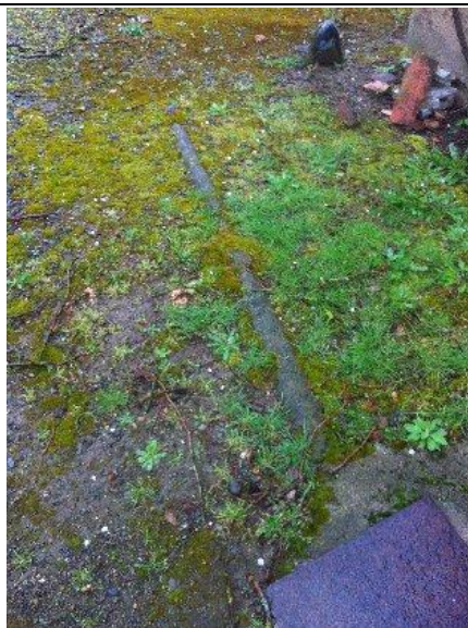
Photo n° DSCN016 Localisation : Maison - Jardin Ouvrage : Conduits de fluides (air, eaux, autres fluides) Partie d'ouvrage : Conduits fibres-ciment Description : Conduits fibres-ciment Localisation sur croquis : Point 016
