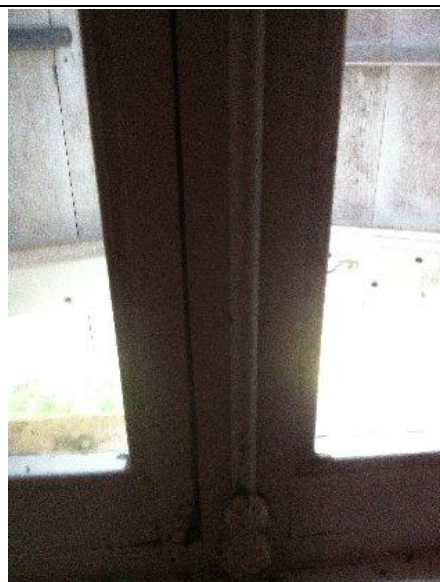
Photo n° repérage Localisation : 0984 UD : Fenêtre intérieure (F1) (partie basse )
