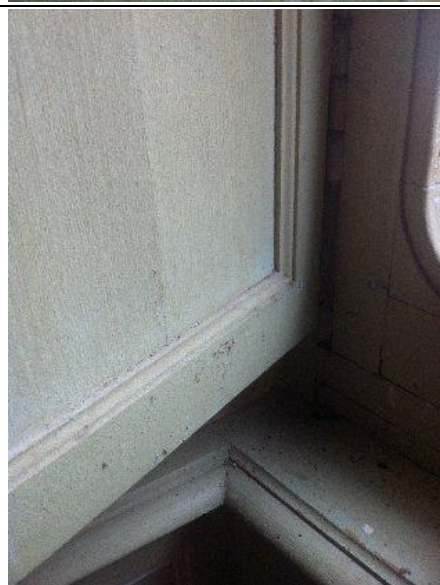
Photo n° repérage Localisation : 0116 UD : Volet intérieur (F1) (partie basse )
