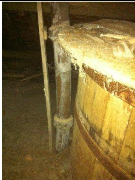
Photo n° DSCN015 Localisation : Maison - Comble Ouvrage : Conduits de fluides (air, eaux, autres fluides) Partie d'ouvrage : Conduits fibres-ciment Description : Conduits fibres-ciment Localisation sur croquis : Point 015
