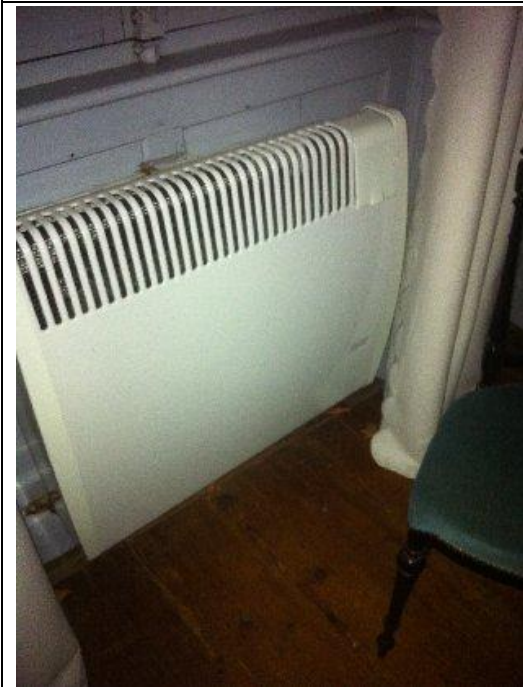
Photo n° DSCN010 Localisation : Étage 1 - Chambre 1 Chaudière AUER (Type : Etanche) Localisation sur croquis : Point 010
