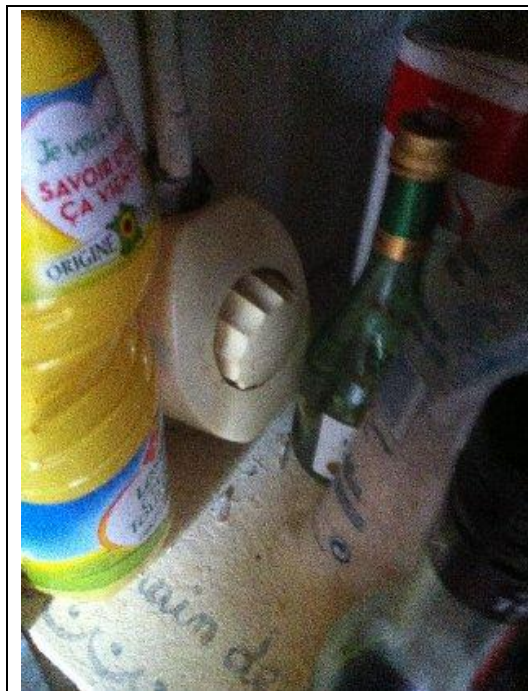
Photo n° Information au moins un robinet de commande d'appareil est présent.
