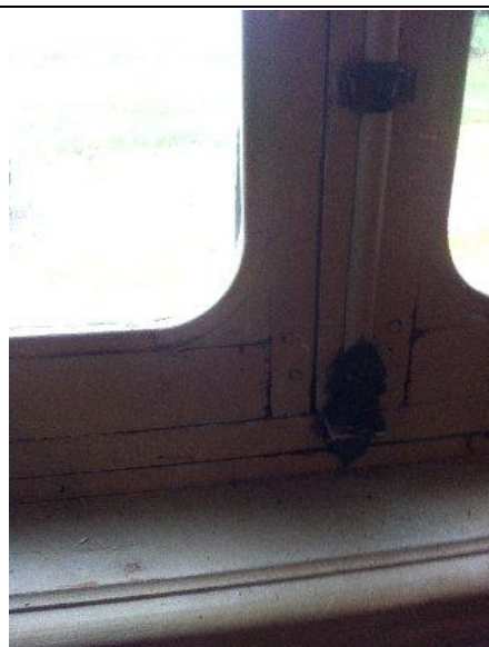
Photo n° repérage Localisation : 0108 UD : Fenêtre intérieure (F1) (partie basse )
