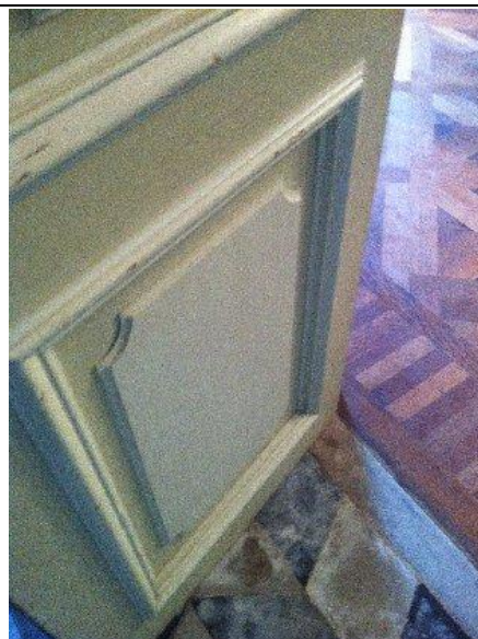
Photo n° repérage Localisation : 0024 UD : Porte (P2) (partie basse )
