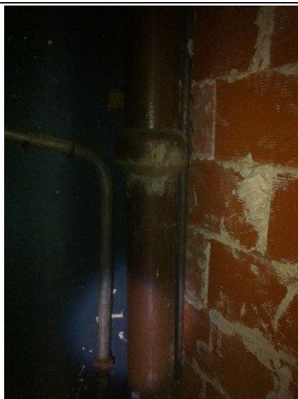
Photo n° DSCN014 Localisation : Étage 1/2 - Placard Ouvrage : Conduits de fluides (air, eaux, autres fluides) Partie d'ouvrage : Conduits fibres-ciment Description : Conduits fibres-ciment Localisation sur croquis : Point 014
