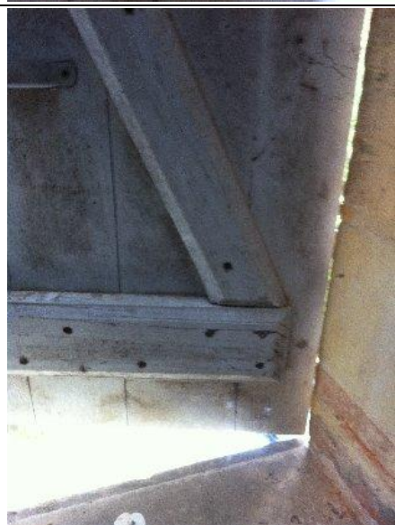
Photo n° repérage Localisation : 0994 UD : Volet extérieur (F1) (partie basse )
