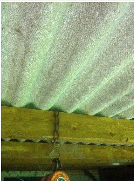
Photo n° DSCN011 Localisation : Dépendance - Abris Ouvrage : Plaques ondulées Partie d'ouvrage : Plaques en fibres-ciment Description : Plaques en fibres-ciment Localisation sur croquis : Point 011
