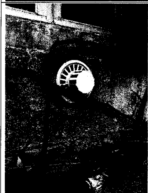
Photo n° Information L'orifice d'évacuation des produits de combustion de l'appareil étanche débouche à l'extérieur d'un bâtiment.
