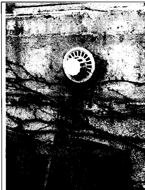
Photo n° Information L'orifice d'évacuation des produits de combustion de l'appareil étanche débouche à l'extérieur d'un bâtiment.
