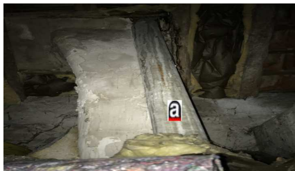
Conduit amiante-ciment - Combles 2
