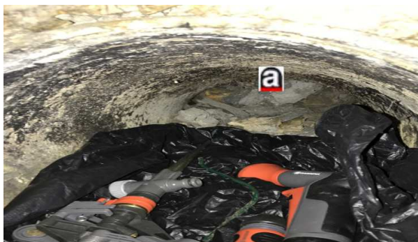
Conduit amiante-ciment - Atelier
