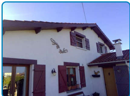
Maison principale Rez de chaussée Extérieur
