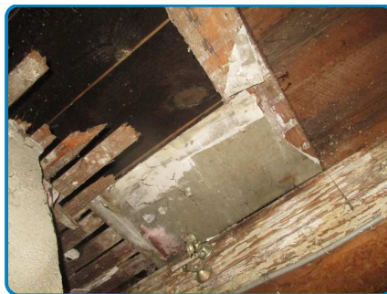
D.O. n° 7 sur Plafond Fragments de plaques fibres ciment
