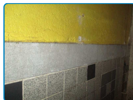
D.O. n° 6 sur Murs A B D (frises) Plaques fibres ciment
