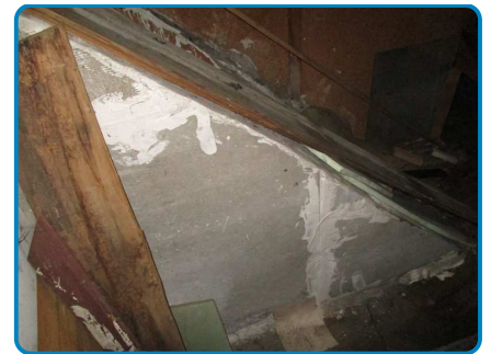
D.O. n° 11 sur Mur montée d'escalier Plaques fibres ciment / B
