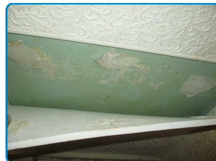
D.O. n° 3 sur Plafond (derrière polystyrène) Plaques fibres ciment Peinture
