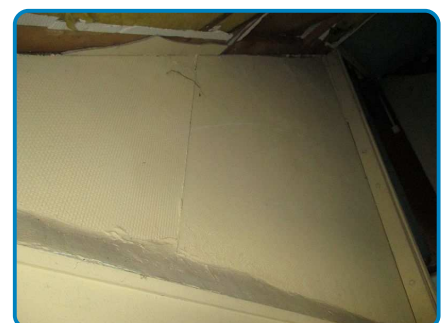
D.O. n° 9 sur Mur montée 2ème étage Plaques fibres ciment Peinture
