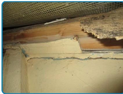
D.O. n° 10 sur Plafond montée 2ème étage Fragments Plaques fibres ciment Peinture
