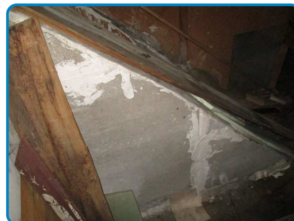
D.O. n° 11 sur Mur montée d'escalier Plaques fibres ciment / B
