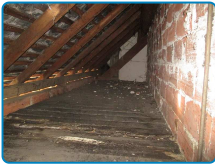
2ème étage Combles
