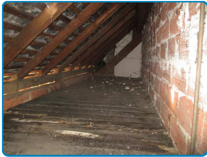
2ème étage Combles
