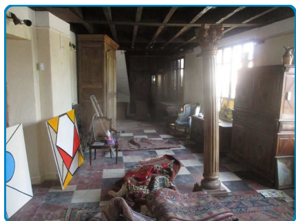
Rez de chaussée Pièce n°2
