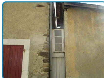
D.O. n° 11 sur Mur montée d'escalier Plaques fibres ciment / B
