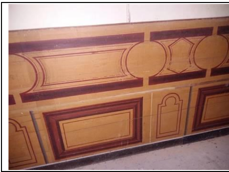
Photo n° PhPb010 Localisation : Rez de chaussée - Salle 9 UD : Parements (mesure 1)
