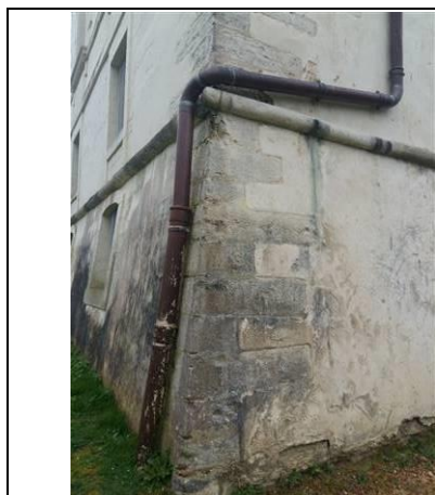
Photo n° PhA003 Localisation : Extérieur - Façades Ouvrage : Conduits de fluides (air, eau, autres fluides) Partie d'ouvrage : Conduits Description : Conduits eaux pluviales métal et PVC
