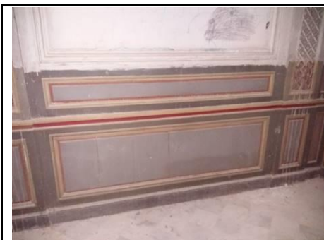
Photo n° PhPb006 Localisation : Rez de chaussée - Gde salle 8 UD : Parements (mesure 1)
