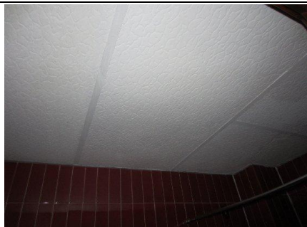
Photo n° D11 (en cours d'analyse) Localisation : Salle d'eau chambres étages, WC étages, cage d'escalier vers R+5 Ouvrage : Plafonds et faux plafonds - Faux-plafonds Partie d'ouvrage : Panneaux et plaques Description : Panneaux en fibrociment au plafond Localisation sur croquis : D11
