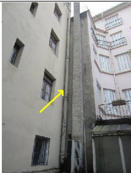
Photo n° D7 Localisation : Étage 1 - Terrasse Ouvrage : Conduits, canalisations et accessoires intérieurs et extérieurs - Conduits de vapeur, fumée, échappement Partie d'ouvrage : Conduit Description : Conduit en fibrociment en terrasse Localisation sur croquis : D7
