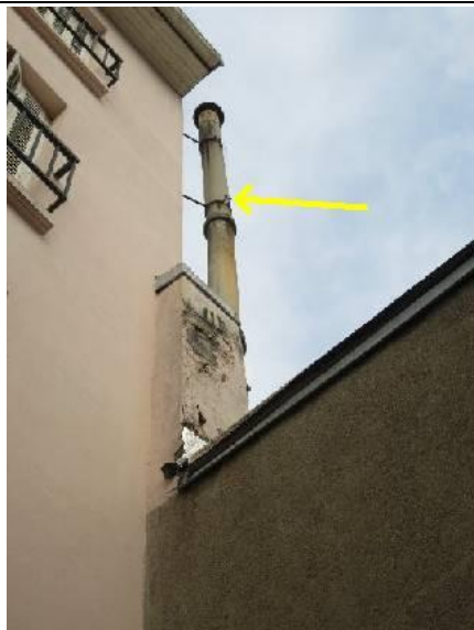
Photo n° D10 Localisation : Bâtiment Ouvrage : Conduits, canalisations et accessoires intérieurs et extérieurs - Conduits de vapeur, fumée, échappement Partie d'ouvrage : Conduit Description : Conduit en fibrociment angle EST Localisation sur croquis : D10
