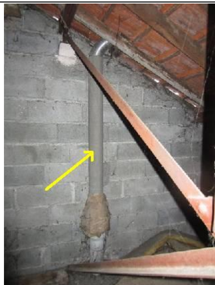
Photo n° D15 Localisation : Combles Ouvrage : Conduits, canalisations et accessoires intérieurs et extérieurs - Conduits de vapeur, fumée, échappement Partie d'ouvrage : Conduit Description : Conduit en fibrociment dans les combles Localisation sur croquis : D15
