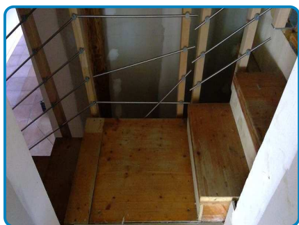
Maison principale 1er étage Dégagement
