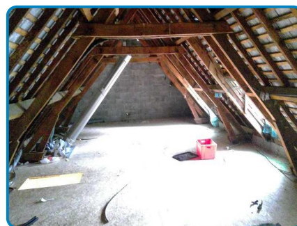
Maison principale 2ème étage Combles
