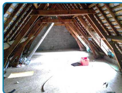
Maison principale 2ème étage Combles
