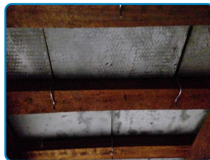
D.O. n° 1 sur Plafond Ardoises fibre-ciment
