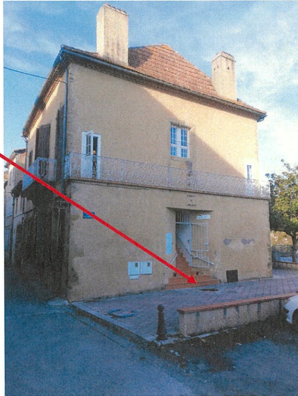
Localisation de la boîte de branchement
