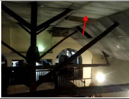
Photo n° PhA001 Localisation : Rez de chaussée - Sanitaires; 2ème étage - Combles habitables Ouvrage : 4 - Plafonds et faux plafonds - Faux plafonds Partie d'ouvrage : Panneaux et plaques Description : Panneaux et plaques
