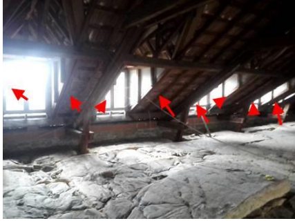
Photo n° PhA002 Localisation : Rez de chaussée - Sanitaires; Rez de chaussée - Dégagement; 1er étage - Coursive; 1er étage - Salle de restaurant; 1er étage - Sanitaires; 1er étage - Pièce 4 Ouvrage : 2 - Parois verticales extérieures et Façades - Façades légères, murs rideaux, bardages, panneaux sandwich Partie d'ouvrage : Plaques Description : Plaques
